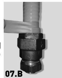
04 Draai de moer met de hand om de FLEXIPIPE te blokkeren Serrer l'écrou pour bloquer le tuyau FLEXIPIPE
