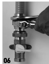
02 Draai de moer minimaal een halve slag los Desserrer l'écrou d'un 1/2 tour minimum
