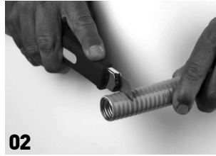
02 De gele polyethyleenmantel verwijderen met een mes Dénuder le FLEXIPIPE à l'aide d'un cutter
