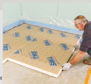
\* La hauteur et l'épaisseur de l'Efirive sont à vérifier au regard du type de chape prévu (se référer aux Avis Technique, DTU... liés à l'ouvrage), ainsi que du revêtement de sol et de sa mise en œuvre. Certificat Acermi n° 08/006/481.
