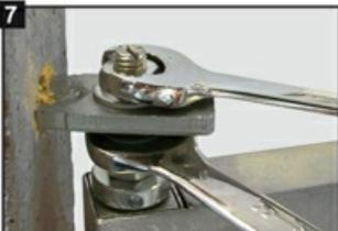
Serrer les 2 écrous-rondelles (clé de 22) en même temps (tout en vérifiant l'aplomb).
