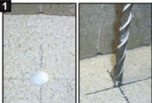
Tracer et pré-percer à Ø8mm (pour être le plus précis possible)
