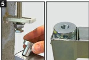
Mettre la bague cylindrique dans le carré du portail. Portail prêt à être fixé.
