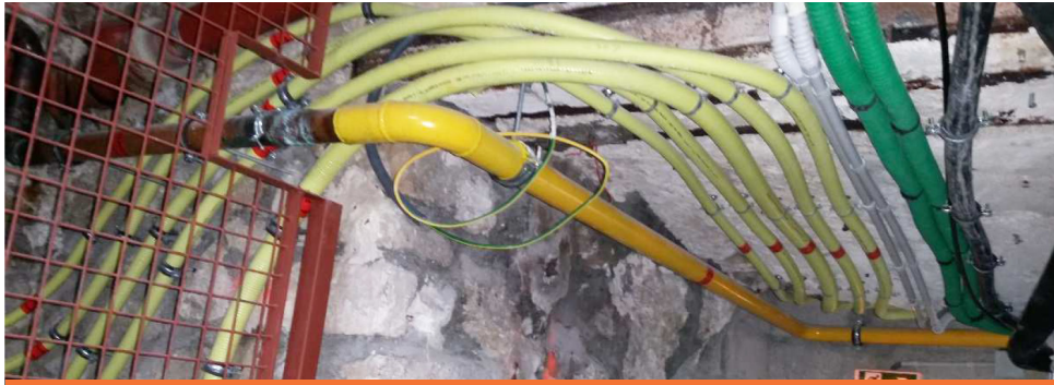
| Rénovation d'une installation gaz dans une cave voûtée d'un site classé monument historique (DN 20 - DN 25 - DN 32)*
