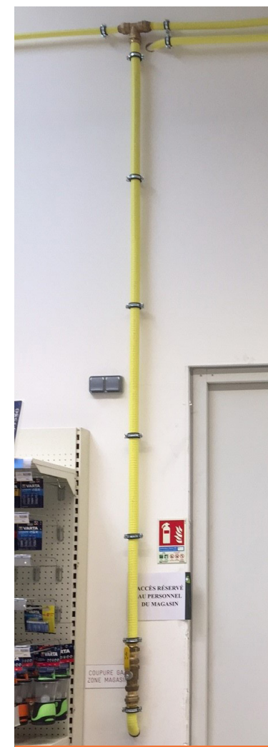
Installation d'un réseau gaz dans une jardinerie avec branchement aréotherme (DN 32).
