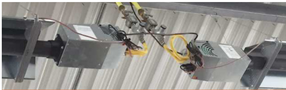
Installation d'un réseau gaz chez un concessionnaire automobile pour alimentation de radiants (DN 32) et d'une cabine de peinture (DN 50)
