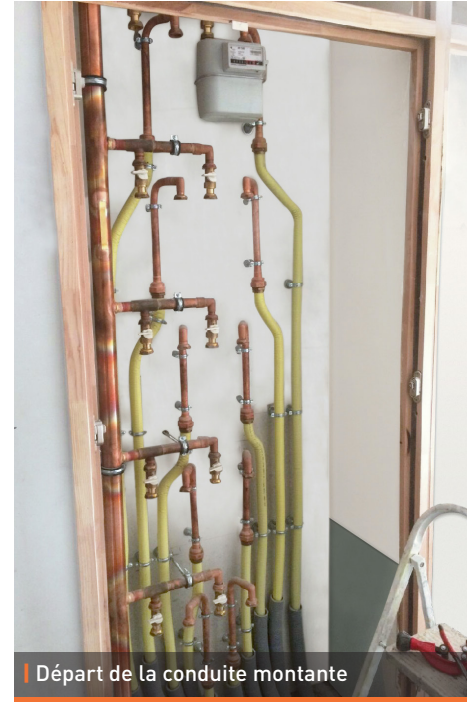
| Installation d'un réseau gaz dans un immeuble collectif en sortie de conduite montante vers le logement (DN 20)
