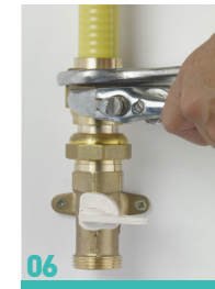
06 Terminer le serrage en butée
