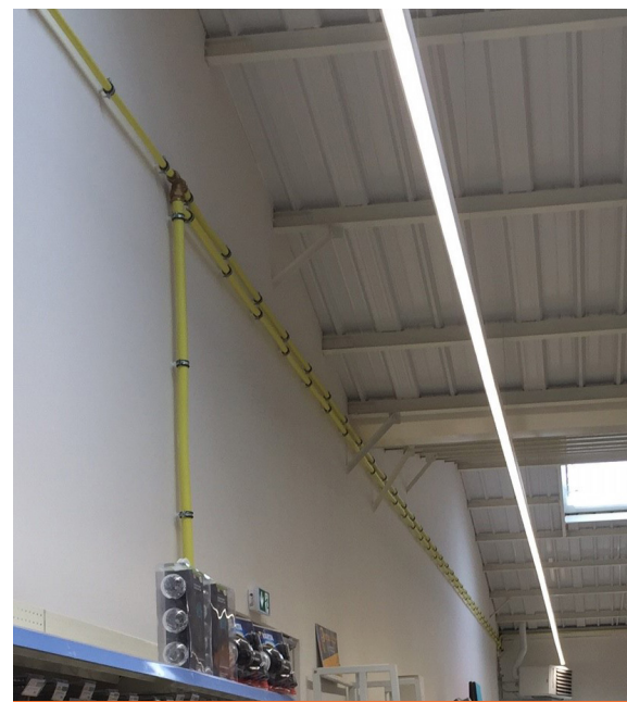
Installation d'un réseau gaz dans une jardinerie avec branchement aréotherme (DN 32).
